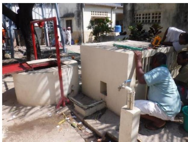
Installation des tuyauteries de conduite d'amenée et branchement de la citerne à partir du puits existant. Photo Gescod
