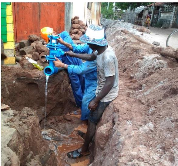
Creusement des tranchées en vue d'extraire les conduites vétustes (à gauche) et les remplacer par les nouvelles (à droite).
