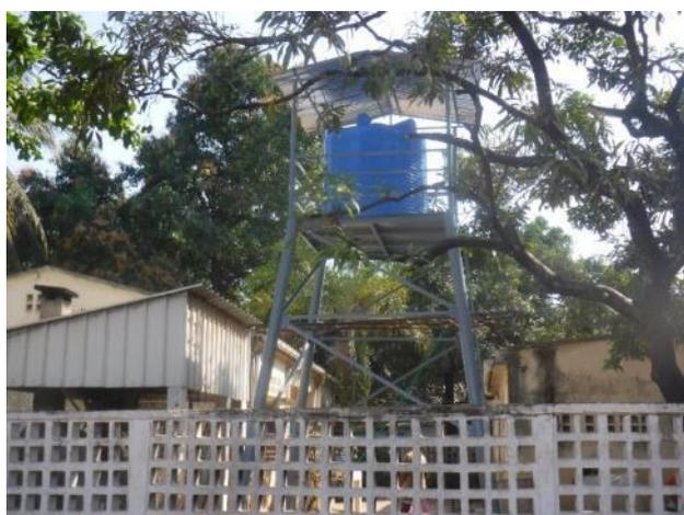
Les installations disposent également d'un abri et de dispositifs de trop plein, vidange, sortie, entrée et d'arrêt automatique ou flotteur). Photo Gescod
