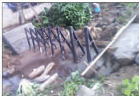
Photo 7 : Vue du piège à embâcle à 8 assemblages sur site 3 achevé (juste après une pluie)
