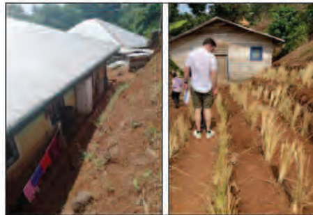
Photos 19a et 19b : Vue des plantations de protection à l'amont de la terrasse (application du schéma de principe B)
