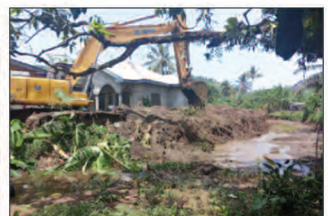
Photo 7 : Curage de la partie amont du pont N°5
