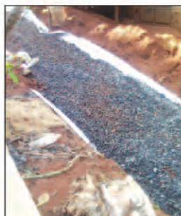
Photos 7a et 7b : Mise en place du massif filtrant protégé par le géotextile
