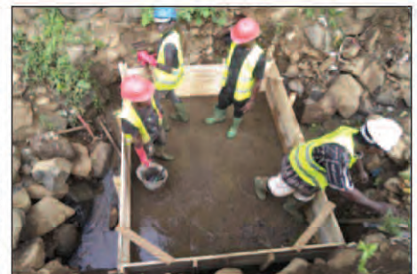
Photo 3 : Coffrage pour le coulage du massif d'ancrage des assemblages sur le site 1
