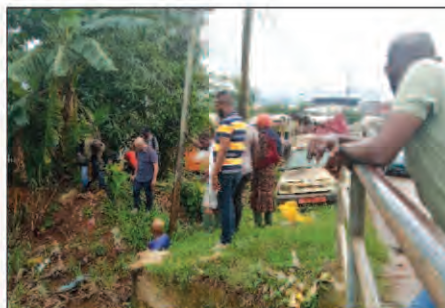
Photo 9 : Identification du point d'observation au pont N°5
