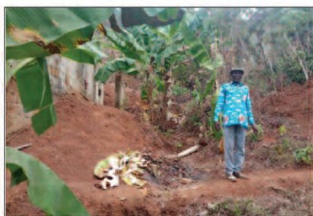
Photo 1 : Vue du talweg naturel avant travaux
