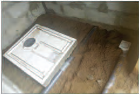
Photos 9a et 9b : Modèles 1 et 2, installation du siège à séparateur d'urine et mise en place du système de collecte des eaux usées de nettoyage de la cabine
