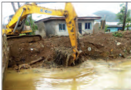
Photo 1 : Curage mécanique en cours à l'amont du pont N° 6
