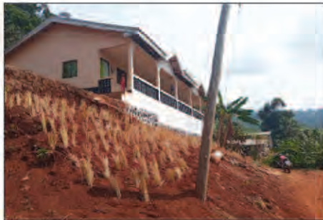
Photo 18 : Vue des plantations de protection en aval de la terrasse (application du schéma de principe A).
