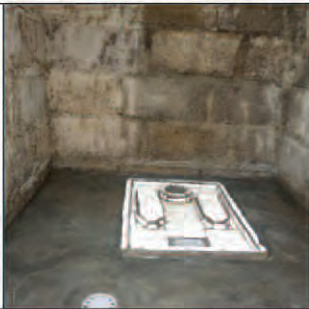
Photos 9a et 9b : Modèles 1 et 2, installation du siège à séparateur d'urine et mise en place du système de collecte des eaux usées de nettoyage de la cabine
