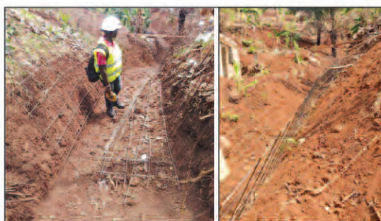
Photos 2a et 2b : Fouilles et ferrailage du drain découvert
