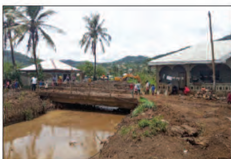
Photo 5 : Vue aval du pont N°6 après curage
