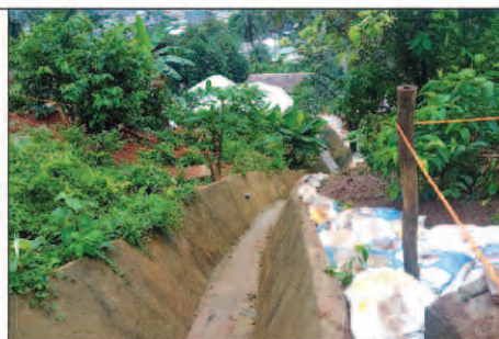
Photos 8a et 8b : Vues du drain principal. Les abords de l'ouvrage sont protégés contre l'érosion latérale par des sacs remplis de terre. A gauche (vue depuis l'aval), à droite (depuis l'amont).
