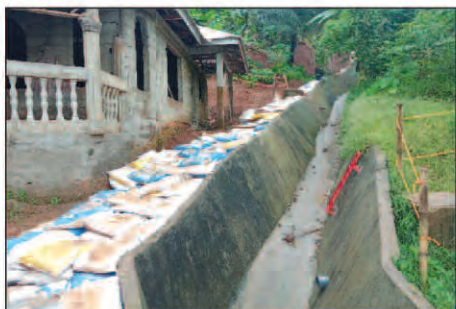
Photos 8a et 8b : Vues du drain principal. Les abords de l'ouvrage sont protégés contre l'érosion latérale par des sacs remplis de terre. A gauche (vue depuis l'aval), à droite (depuis l'amont).
