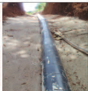
Photos 5a et 5b : Fouilles et pose des tuyaux PVC crépinés
