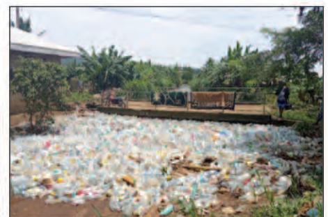
Photo 4 : Vue amont du pont N°6 avant curage
