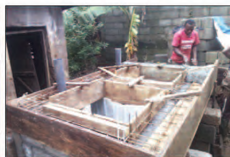
Photo 5 : Modèle 2, vue de la fosse en construction
