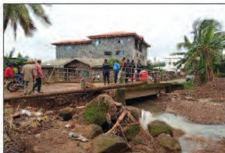
Photo 8 : Identification du point d'observation au pont N°4
