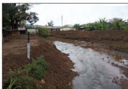
Photo 6 : Vue amont du pont N°4 après curage
