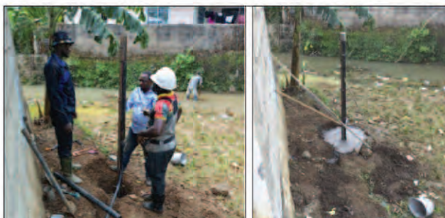
Photos 4a et 4b : Installation de l'unité centrale d'un capteur de pression et vue du câble de connexion au module immergé
