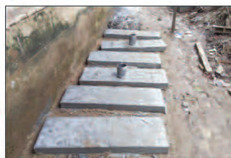
Photo 8 : Modèles 1 et 2, dalettes amovibles en cours de fabrication
