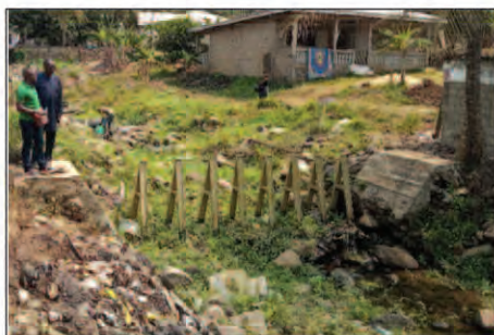
Photo 6 : Vue du piège à embâcles à 8 assemblages du site 3 achevé (en période d'étiage)
