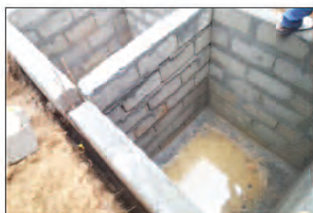
Photo 3 : Modèle 1, vue de la fosse en construction
