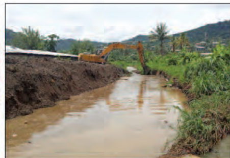
Photo 2 : Vue aval du pont N°6 après curage
