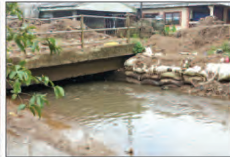
Photo 10 : Vue des sacs de terre impactés après de fortes pluies, sans être emportés par l'inondation
