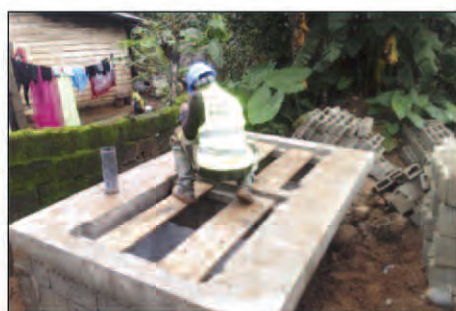
Photo 6 : Modèle 2, chaînage de la fosse achevé
