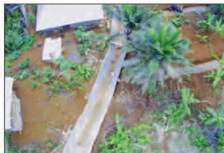
Photo 9 : Vue aérienne du drain principal et de deux tranchées (à droite)
