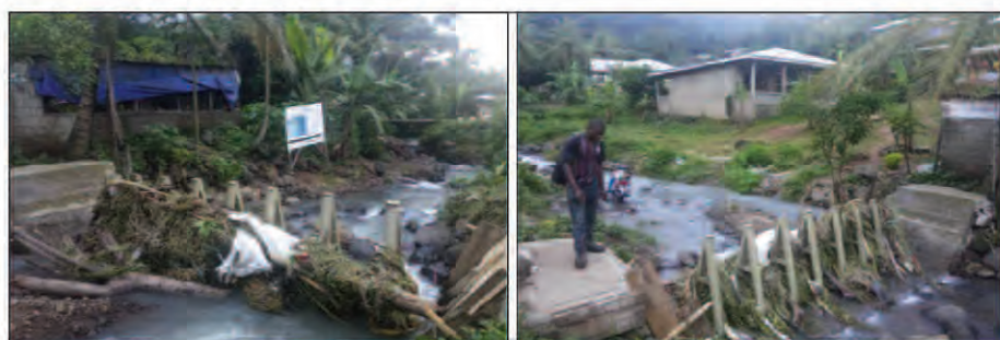
Photo 9 : Vues amont et aval du piège à embâcle du site 3 après une forte pluie
