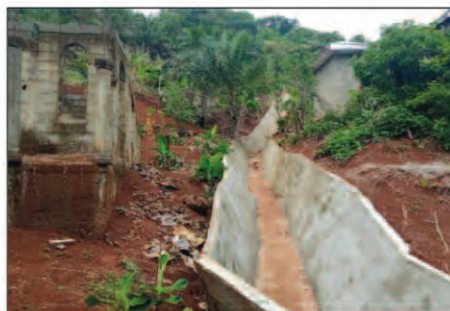
Photo 4 : Vue du drain principal après décoffrage
