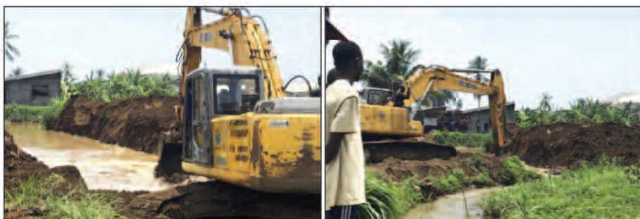
Photos 3a et 3b : Curage mécanique en amont du pont n°5
