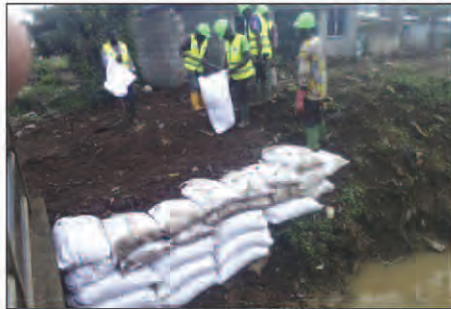
Photo 9 : Stabilisation d'une berge avec les sacs de terre
