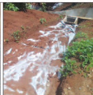
Photos 7a et 7b : Mise en place du massif filtrant protégé par le géotextile
