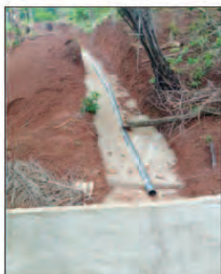
Photos 5a et 5b : Fouilles et pose des tuyaux PVC crépinés
