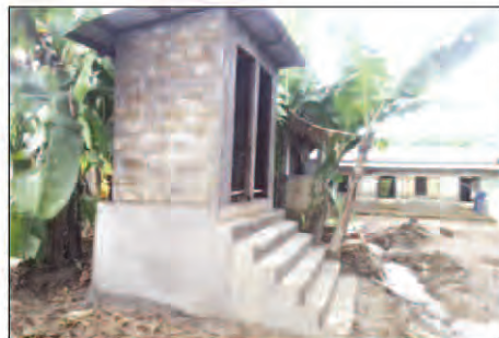
Photo 11 : Modèle 2, toilette surélevée à six marches d'escaliers
