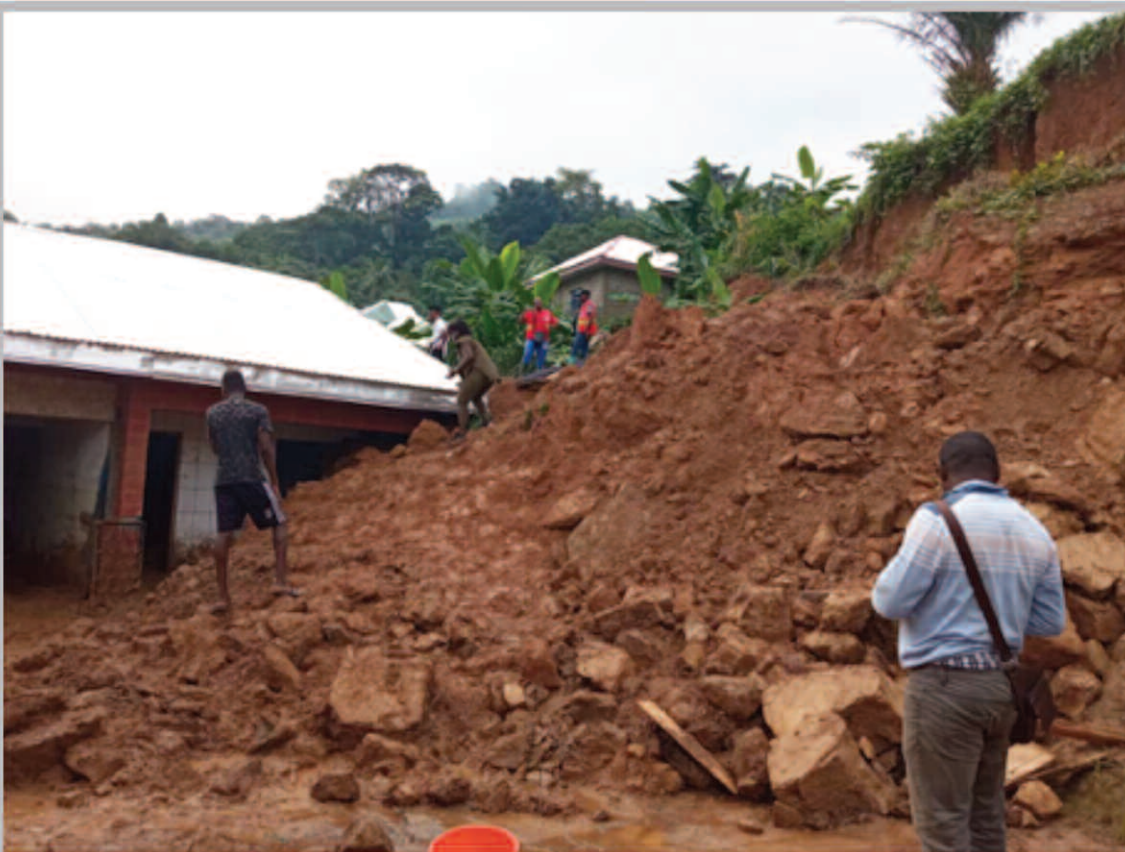
Glissement de terrain du 18 juillet 2023, quartier Makuka - Limbé
