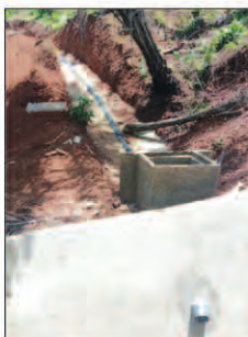
Photo 6 : Aménagement de regards de contrôle et raccordement du tuyau au drain principal des tuyaux PVC crépinés
