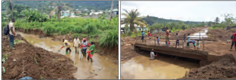
Photos 8a et 8b : Curage manuel associé au curage mécanique
