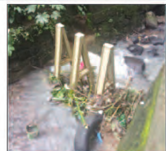
Photo 5 : Vue du piège à embâcle à 3 assemblages du site 2 achevé (après une pluie)
