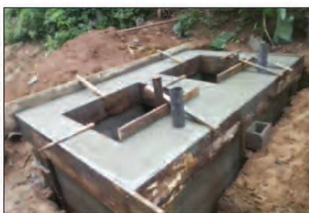
Photo 4 : Modèle 1, chaînage de la fosse achevé
