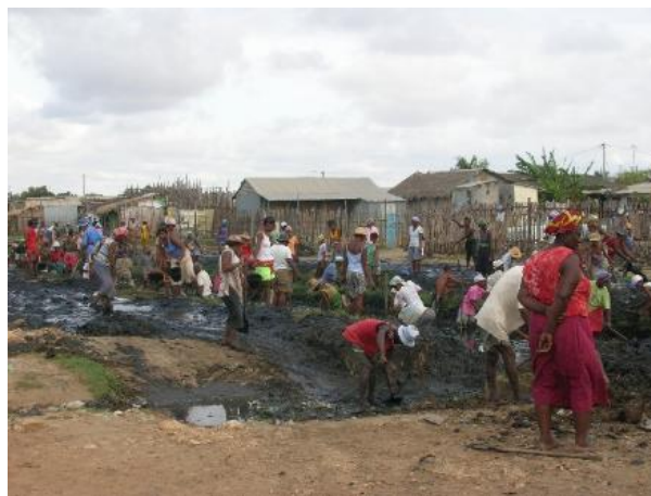
Curage collectif du canal principal. © Gescod
