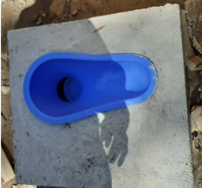
Photos d'une cuvette (à gauche) et d'un siège (à droite) mis en place avec leur dalle
