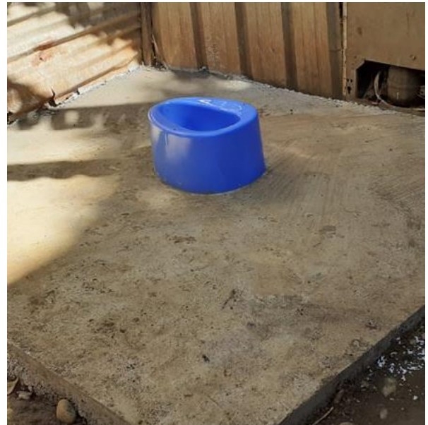
Photos d'une cuvette (à gauche) et d'un siège (à droite) mis en place avec leur dalle
