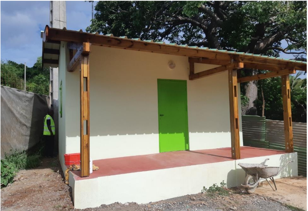
Photo des travaux de la laverie – mars 2020
