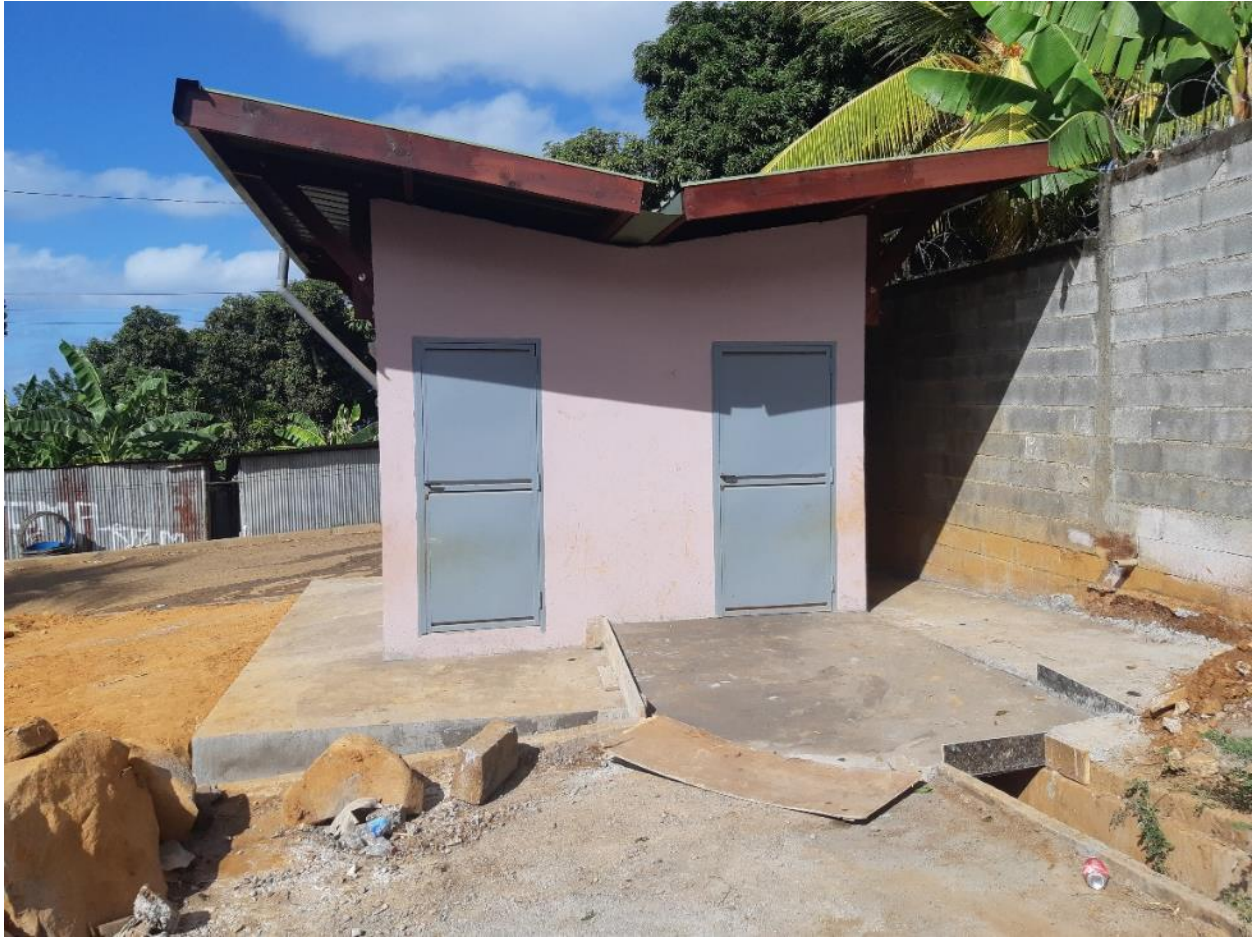
Photo vue du côté du parking – accès PMR
