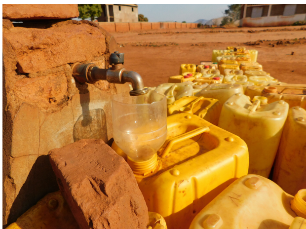
Borne fontaine d'Andriba à réhabiliter.
