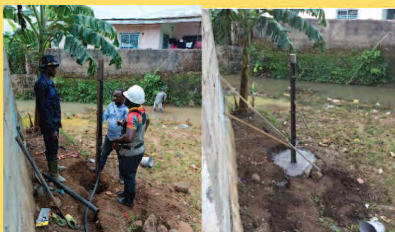
Installation de l'unité centrale d'un capteur de pression et vue du câble de connexion au module immergé
