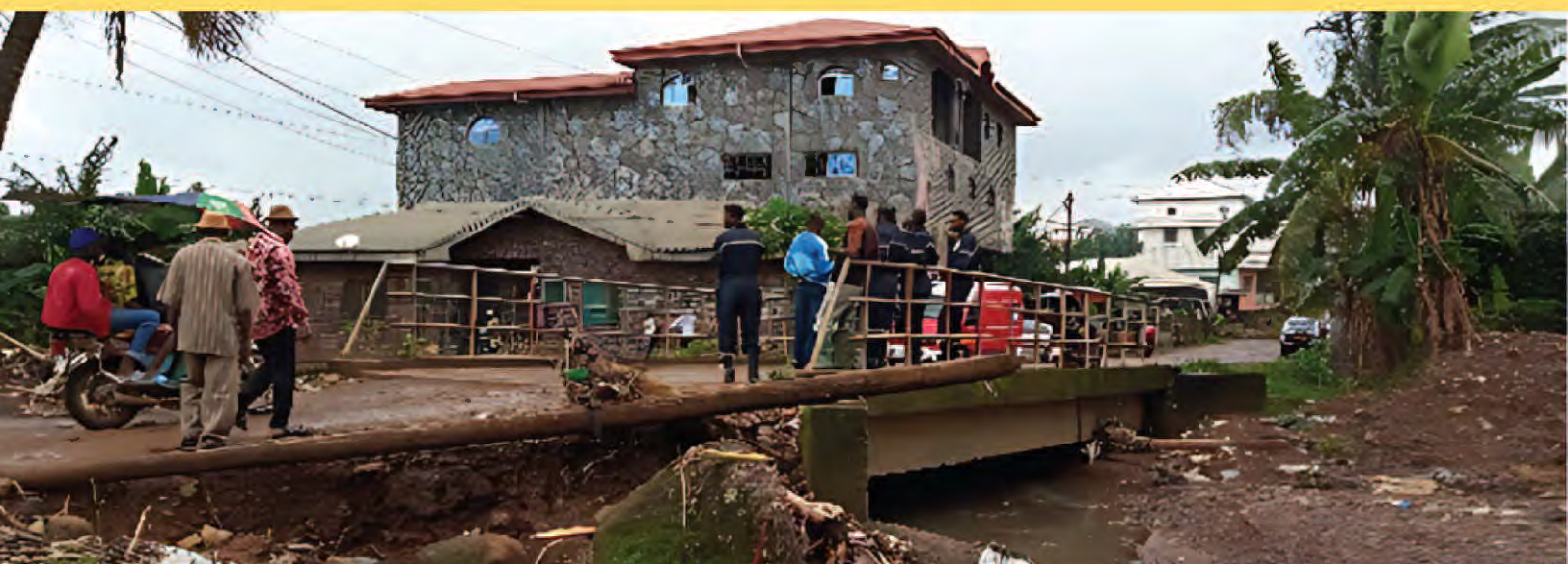
Identification du point d'observation au pont N°4
