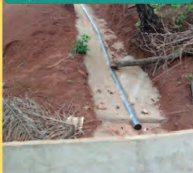
Fouilles et pose des tuyaux PVC crépinés
