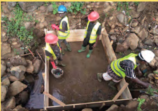
Coffrage pour le coulage du massif d'ancrage des assemblages sur le site 1
