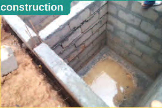
Modèle 1 : vue de la fosse en construction
