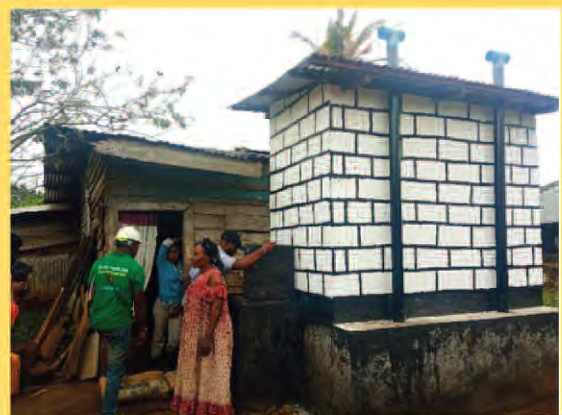
Modèles 1 et 2 : vue arrière de la latrine et des tuyaux de ventilation
