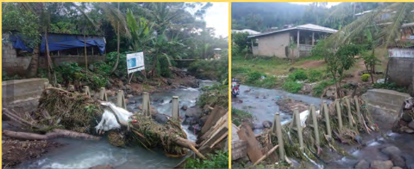
Vues amont et aval du piège à embâcle du site 3 après une forte pluie
