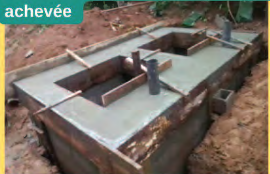
Modèle 1 : dalettes amovibles en cours de fabrication
