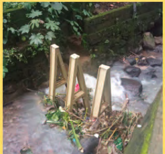
Vue du piège à embâcle à 3 assemblages du site 2 achevé (après une pluie)
