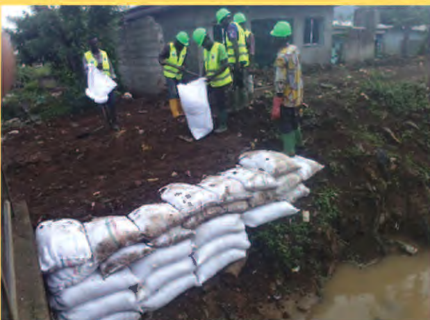
Stabilisation d'une berge avec des sacs de terre
