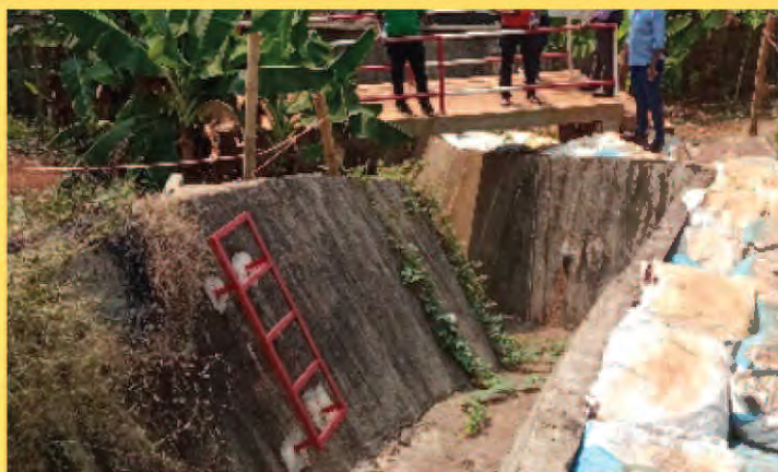
Vue de l'échelle de service et de la passerelle piétonne à l'aval du drain principal
