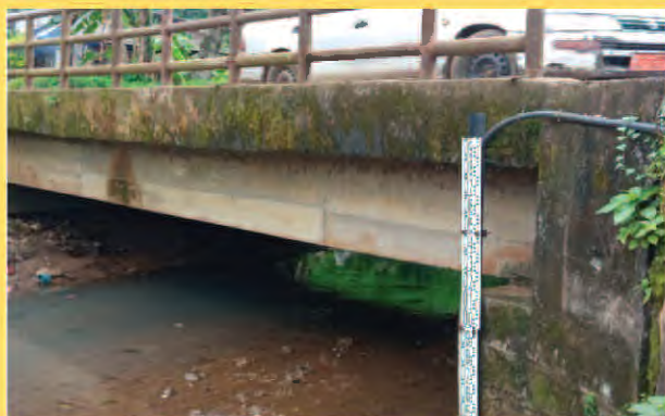
Vue d'une station limnimétrique et du câble de connexion du module immergé du capteur de pression à l'unité centrale installée sur la berge
