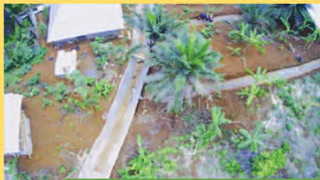
Vue aérienne du drain principal et de deux tranchées (à droite)
