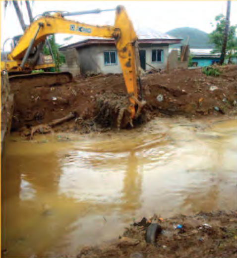
Curage mécanique en cours
