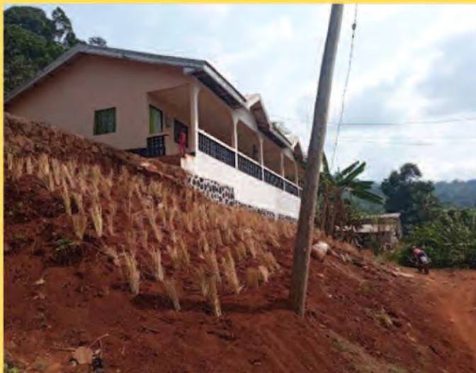
Vue des plantations de protection en aval de la terrasse
