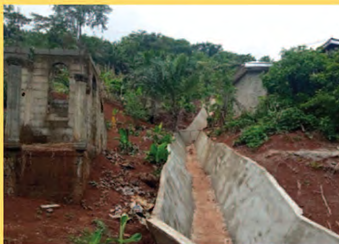
Vue du drain principal après décoffrage
