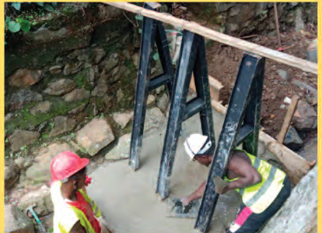
Travaux de scellage des assemblages IPN dans le massif sur le site 2
