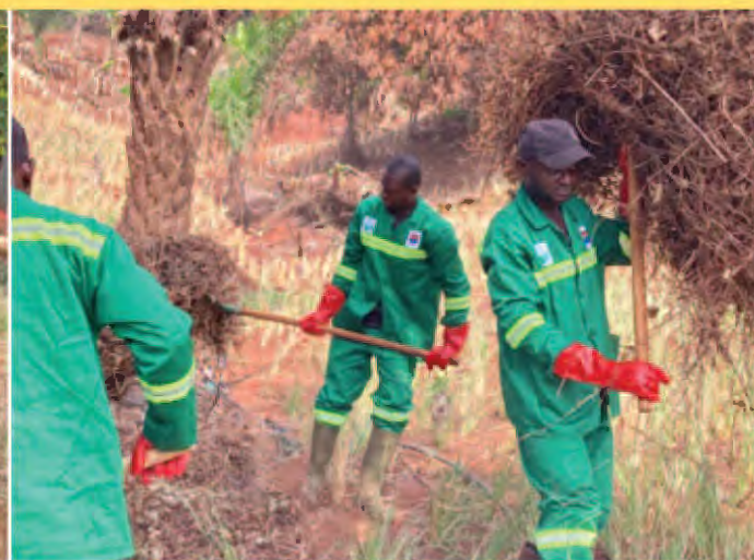
Nettoyage du site
