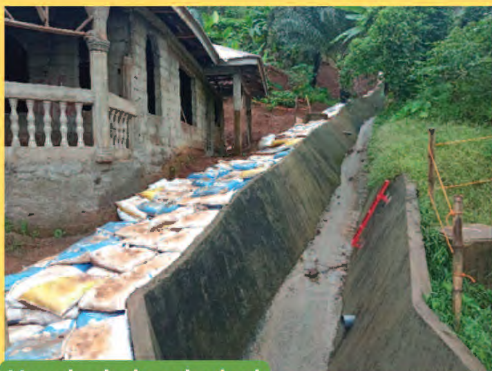
Vue du drain principal
