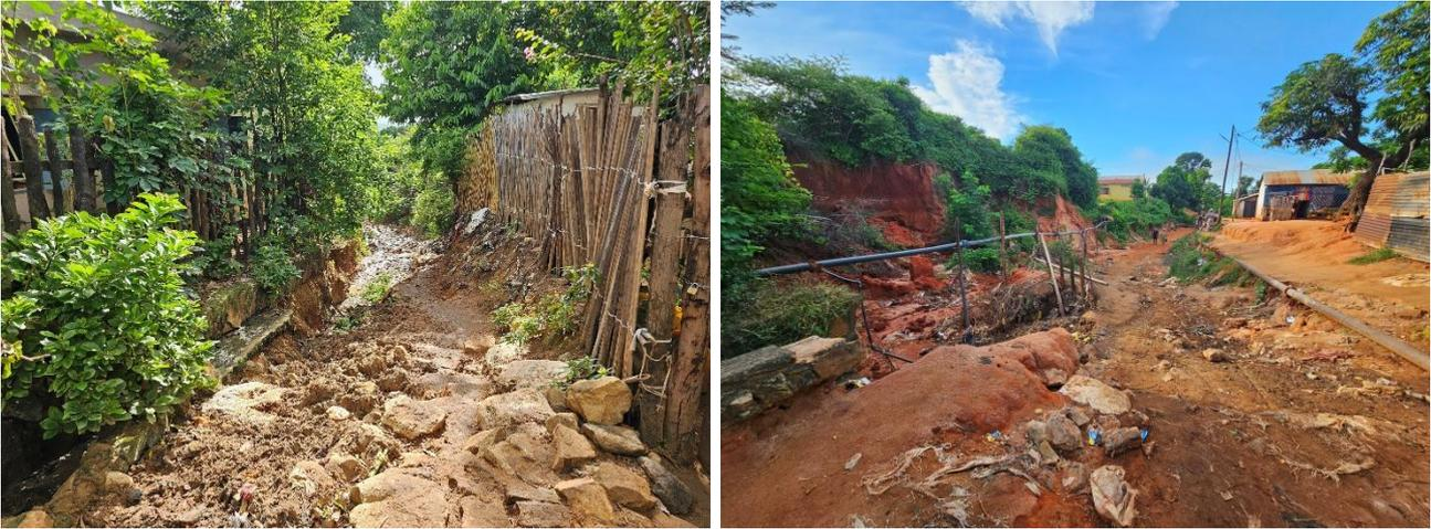
Erosion des pistes et des routes par les eaux pluviales (sur la photo de droite l'on peut voir une conduite d'alimentation en eau potable de la JIRAMA, initialement enterrée, que l'érosion de la piste a entièrement mise à nu.
