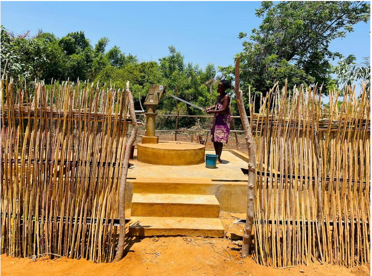
Puits d'Antananaribe, avec sa clôture identifiant le périmètre de protection rapprochée de la ressource en eau. © Gescod
