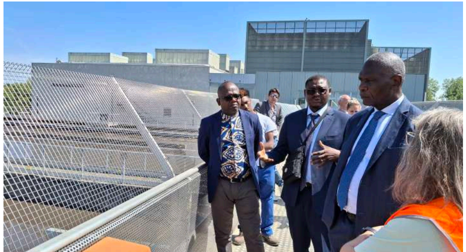
Visite d'une station d'épuration des eaux usées à Reims par les équipes de la mairie de Brazzaville et de la Congolaise des Eaux © Grand Reims
